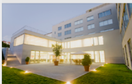
Residência Montepio Breiner (Porto)
